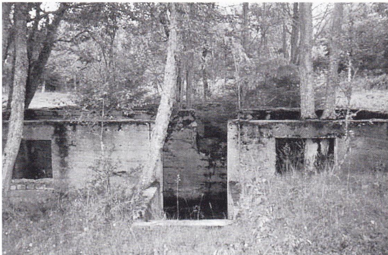
Grunnmuren til voktervillaen i 2001. Herbodde vokteren, vanligis en lærling/person som var under opplæring og en husholderske. I kjelleren var det et eget kjølerom hvor det var stablet inn isblokker for å kjøle ned revmaten. Bildet er tatt mot vest.
